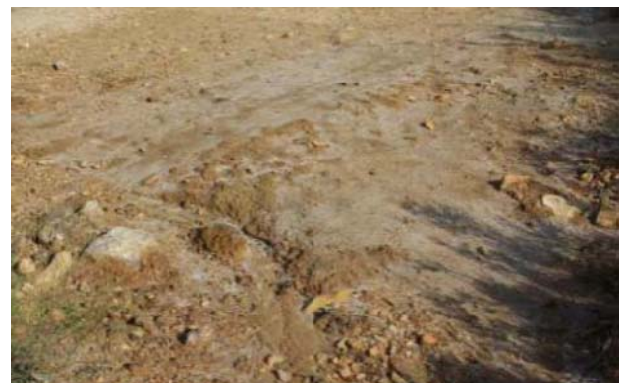
Figura 13: Eflorescencias salinas por capilaridad.
